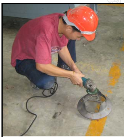
(1) งานเจียรตบแต่งก่อนการปรับปรุง
