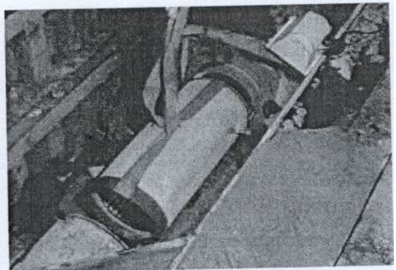
รูปที่ 11 การค้ำต่อคอนกรีตที่มีท่อเหล็กเป็นท่อนวงใน
