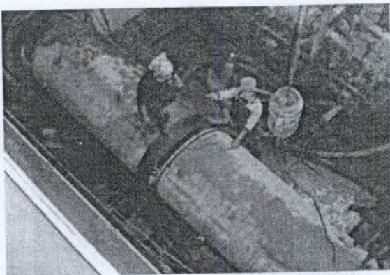
รูปที่ 10 การค้ำต่อเหล็กเหนียวสองชั้น
