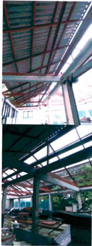
ภาพที่ 3.23 แสดงโครงสร้างหลังคาของอาคาร
