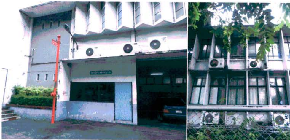
ภาพที่ 3.24 แสดงงานเครื่องปรับอากาศ
