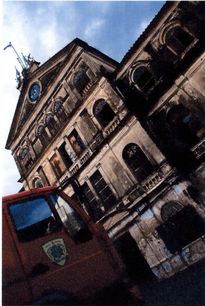
ภาพที่ 1.1 แสดงสภาพอาคารในปัจจุบัน
