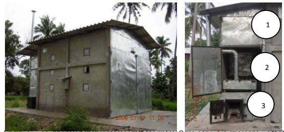
รูปที่ 1 โรงบ่มแบบบัลค์และชุดให้ความร้อน (1.พัดลม 2.ชุดแลกเปลี่ยนความร้อน 3.ห้องเผาไหม้)
