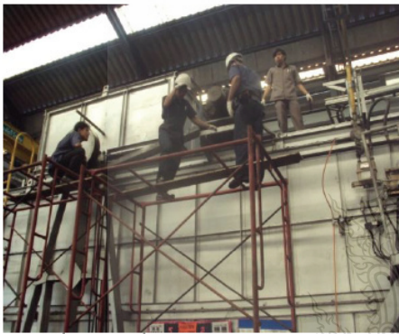
รูปที่ 4 การเปลี่ยนพลูเลย์ของเตาอบอลูมิเนียม
