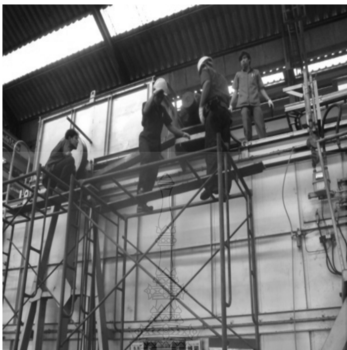
ภาพที่ 3.15 การเปลี่ยนพลูเกิ้ลของเตาอบลูมิเนียม
