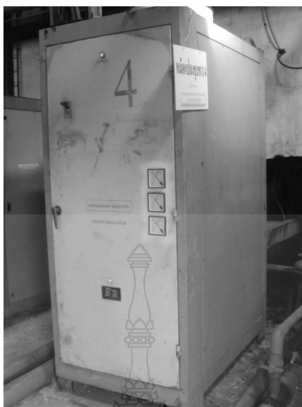
ภาพที่ ก.3 หม้อแปลงชุกอลูมิเนียมแบบระบายความร้อนด้วยอากาศ
