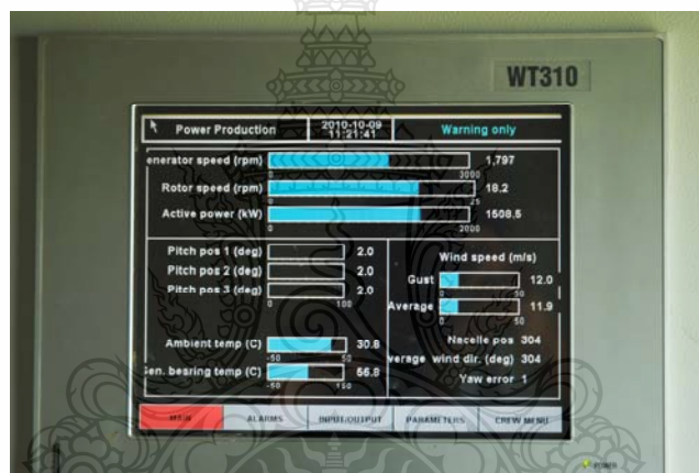
ภาพที่ ก.4 อุปกรณ์ควบคุมด้านล่างภายในเสากังหันลม
