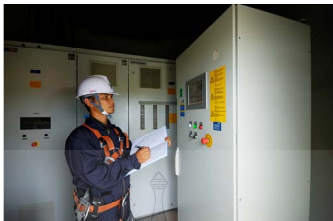
ภาพที่ ก.4 อุปกรณ์ควบคุมด้านล่างภายในเสากังหันลม
