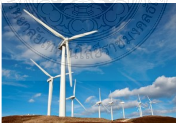
ภาพที่ 2.18 กังหันลมแกนนอน [8]
