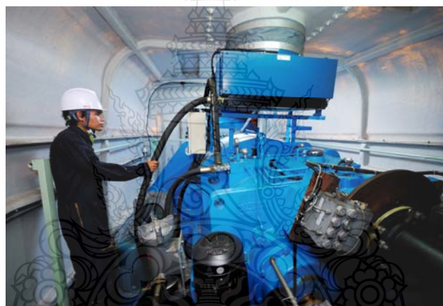
ภาพที่ ก.2 เกียร์ทดความเร็วรอบ
