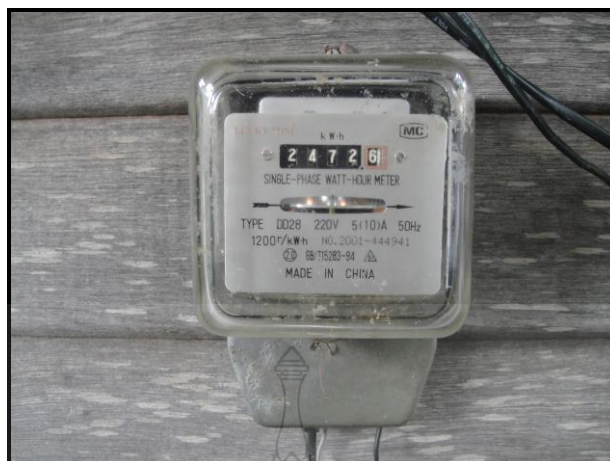
ภาพที่ 3.8 กิโลวัตต์ชั่วโมงมิเตอร์ SINGLE – PHASE WATT – HOUR METER
