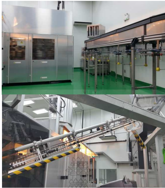
ภาพที่ 4.14 ติดตั้งเครื่องเป่าขวดและสายพานลำเลียง Preform บรรจุภัณฑ์ขวดน้ำดื่มพลาสติก (ขวดเปล่า) ในช่วงหลังการปรับปรุง
