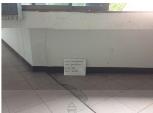
รูปที่ 4.4 รอยร้าวพื้นและผนังชั้นที่ 4 ของอาคารสำนักงานเทศบาลเมืองชลบุรี
