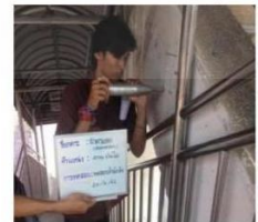
รูปที่ 2 วิธีการทดสอบกำลังอัดประลัยของโครงสร้างคอนกรีต โดยใช้ค้อนกระแทกแบบชมิทท์
