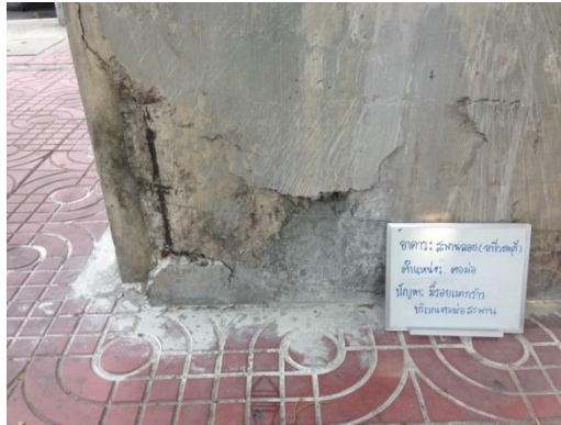
รูปที่ 4.2 การแตกร้าวและหลุดร่อนของโครงสร้างตอม่อของสะพานลอยคนเดินข้าม วิทยาลัยอาชีวศึกษาชลบุรี
