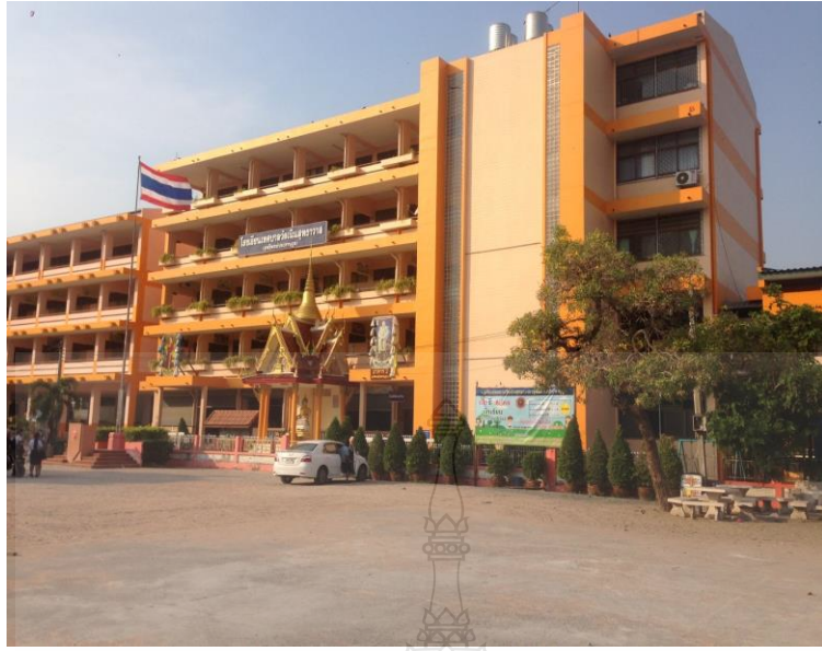
รูปที่ ฉ.1 หาดำเนินของอาคารคอนกรีตเสริมเหล็กที่ใช้ในการศึกษา
