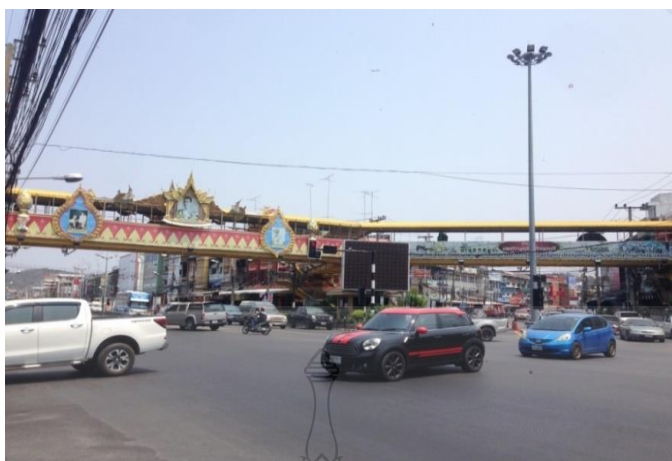
รูปที่ 3.3 สภาพแวดล้อมโดยรอบของสะพานลอยคนเดินข้ามแยกเฉลิมไทย
