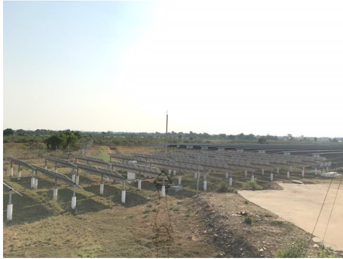
รูปที่ 4.4 การติดตั้งระบบป้องกันฟ้าผ่าของโรงไฟฟ้าพลังงานแสงอาทิตย์
