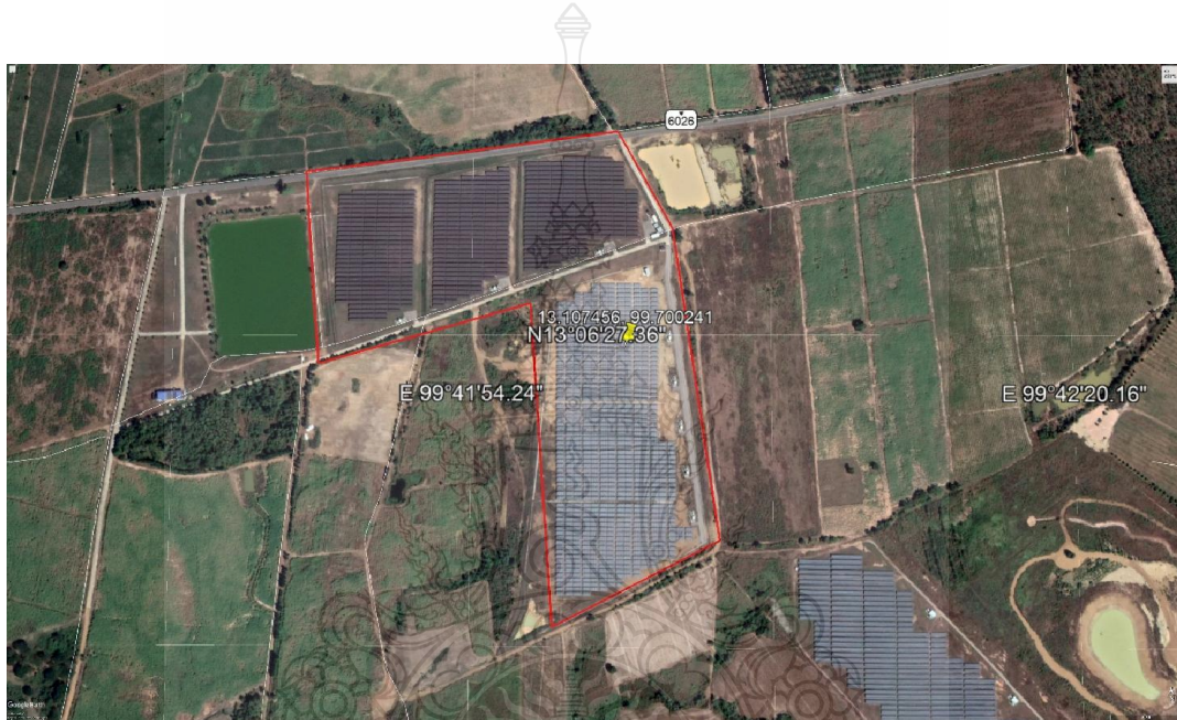
รูปที่ 3.2 โรงไฟฟ้าพลังงานแสงอาทิตย์ชนิดผลึกรวมซิลิคอน ขนาดพื้นที่ 95 ไร่
