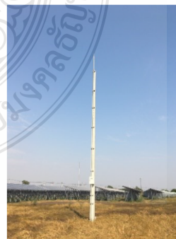
รูปที่ 6 เสาการติดตั้งหัวล่อฟ้า ESE
