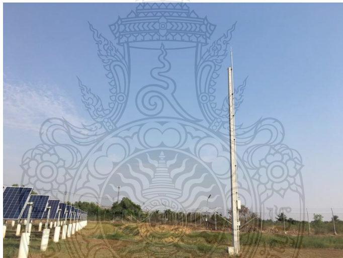
รูปที่ 4.5 ลักษณะการติดตั้งเสาหล่อฟ้า
