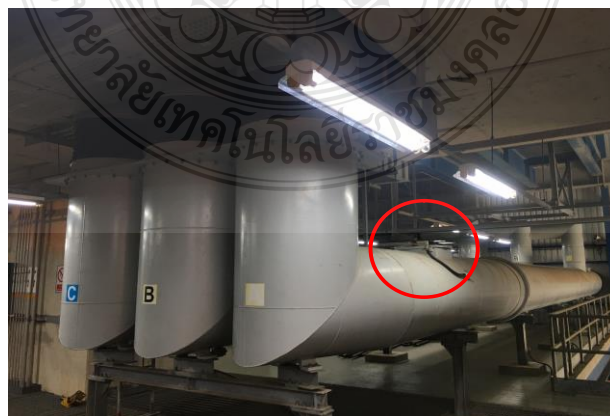
รูปที่ 4.9 จุดที่ทำการตรวจสอบหาสาเหตุที่สตรัมเทอร์โบไนน์ 10 เฟส A [16]
