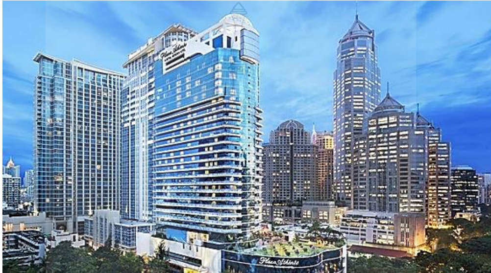
รูปที่ 1.2 อาคารโรงแรมพลาซ่าแอทธินี
