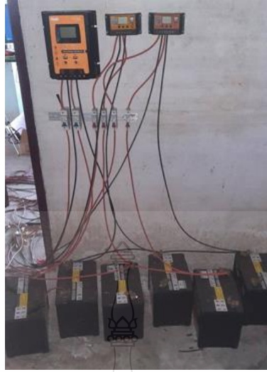
รูปที่ 3.30 แบตเตอรี่ จำนวน 6 ลูกต่อแบบอนุกรมและขนานกันตามลำดับเพื่อให้มีความจุ 24 V , 300 A และควบคุมโดยชาร์คอนโทรลเลอร์ จำนวน 3 ชุด
