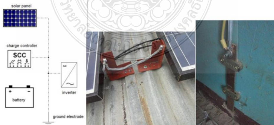
รูปที่ 2.47 การต่อสายดิน
