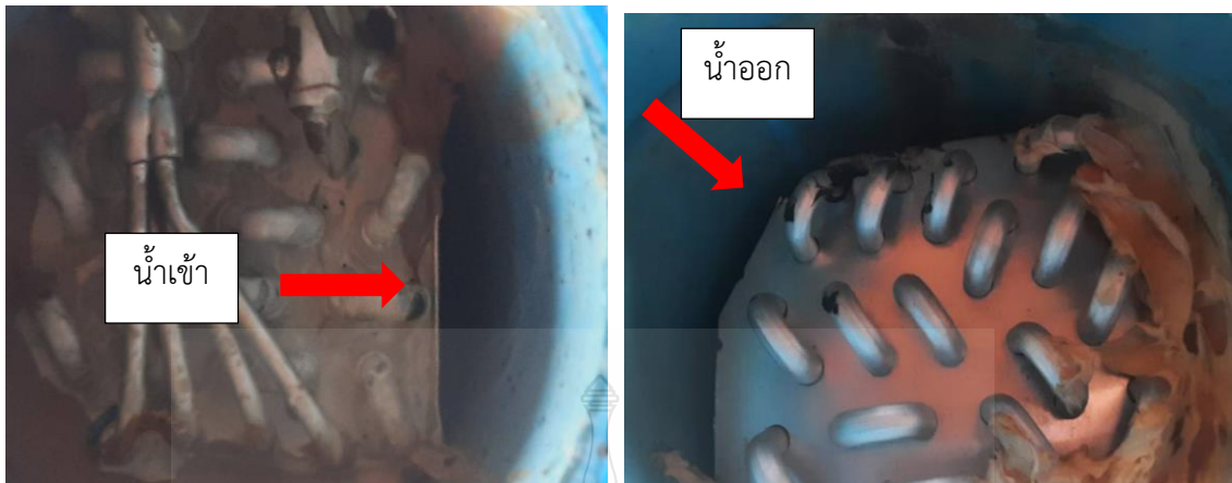
รูปที่ 3.10 แสดงเครื่องแลกเปลี่ยนความร้อนแบบเปลือกและท่อ ทางเดินน้ำเย็นและท่อสารทำความเย็นเดินผ่านทั้งหมด 32 ครั้ง
