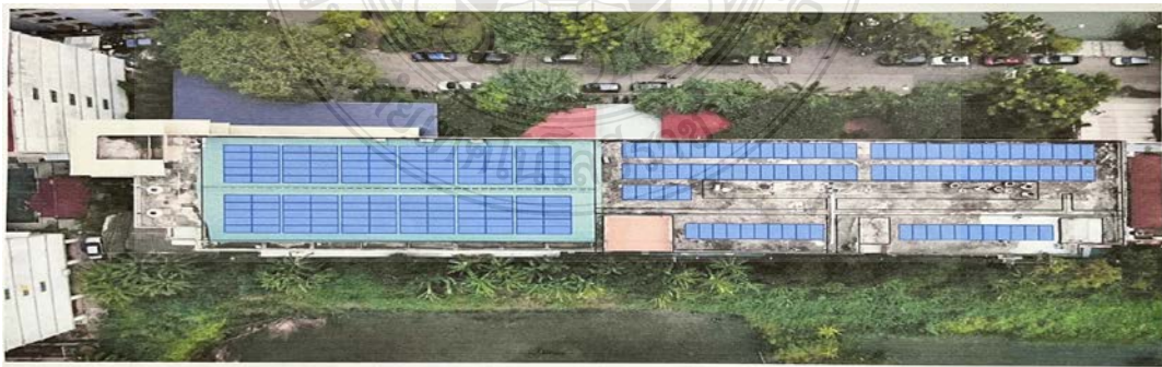
รูปที่ 3.16 การติดตั้งระบบพลังงานแสงอาทิตย์ขนาด 200 kW บนอาคาร
