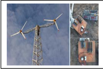
รูปที่ 3 การติดตั้งกังหันลมต้นแบบเพื่อการผลิตไฟฟ้าทดสอบและเก็บข้อมูลในการทำงาน
