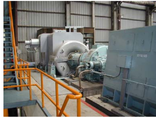
รูปที่ 4 กังหันไอน้ำขับเคลื่อนเครื่องกำเนิดไฟฟ้า
