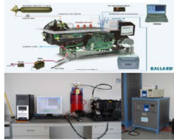
รูปที่ 3: การติดตั้งส่วนประกอบต่าง ๆ ของ Module ที่ทำการทดสอบ เปิดคอมพิวเตอร์ โปรแกรม BALLARD Nexa Mon OEM 2.0 Control & Monitoring Application เพื่อบันทึกข้อมูลการ
