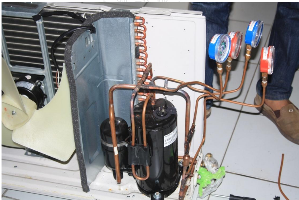
รูปที่ ก.16 ติดตั้งเกจวัดความดัน
