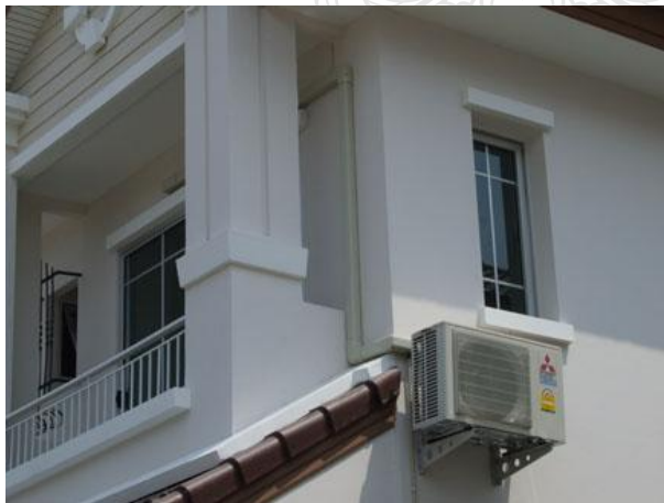
รูปที่ 1.3 แสดงการติดตั้งเครื่องปรับอากาศ
