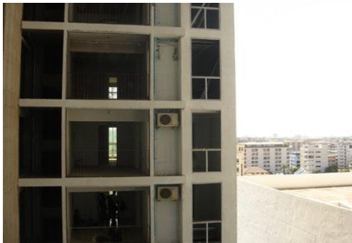
รูปที่ 1.2 พื้นที่ในการติดตั้งเครื่องปรับอากาศ
