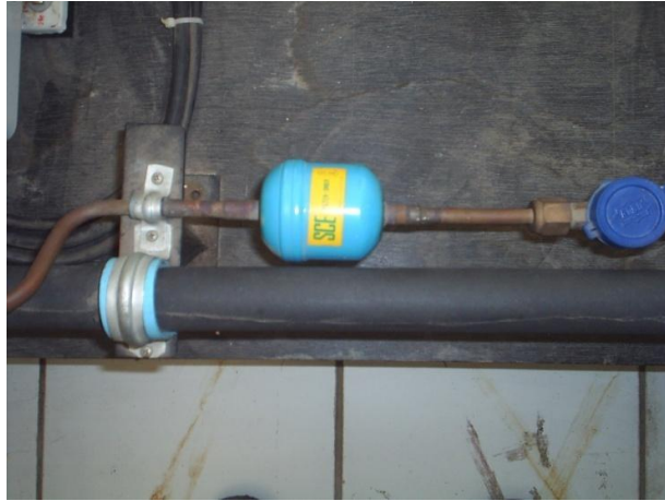
รูปที่ 2.2 อุปกรณ์กรองและเก็บความชื้นในวงจร
