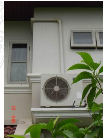
รูปที่ 1.3 แสดงการติดตั้งเครื่องปรับอากาศ
