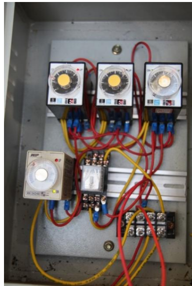
รูปที่ 3 ชุดควบคุมเครื่องปรับอากาศ
