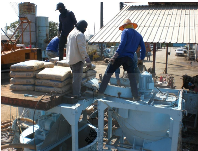
ภาพที่ ฅ.3 การเทปูนซีเมนต์ลงเข้า Silo
