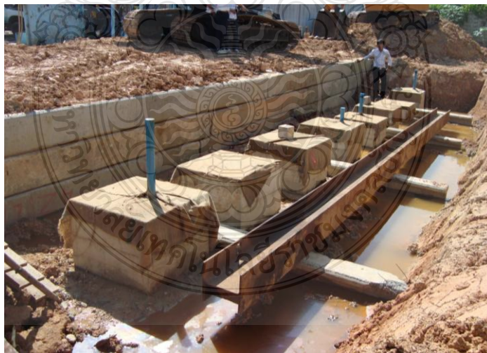
ภาพที่ 3.15 ลักษณะการวาง Reference Beam
