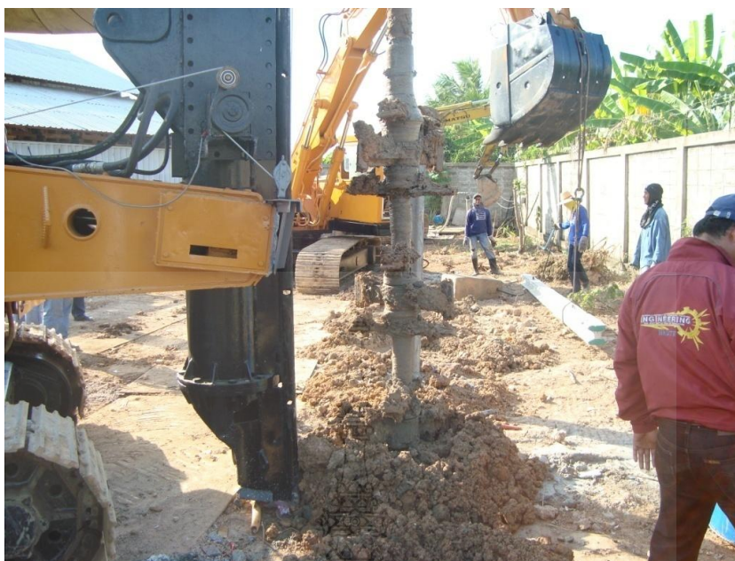
ภาพที่ ฅ.7 ทำการเจาะก่อสร้างเสาเข็มดินซีเมนต์ตามทีออกแบบ
