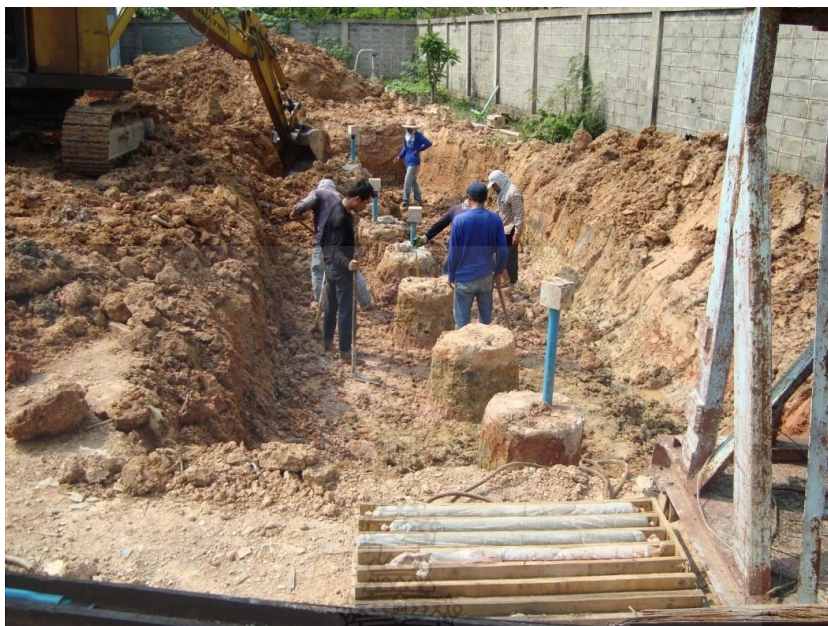
ภาพที่ ฉ.17 การขุดเปิดหัวเสาเข็ม
