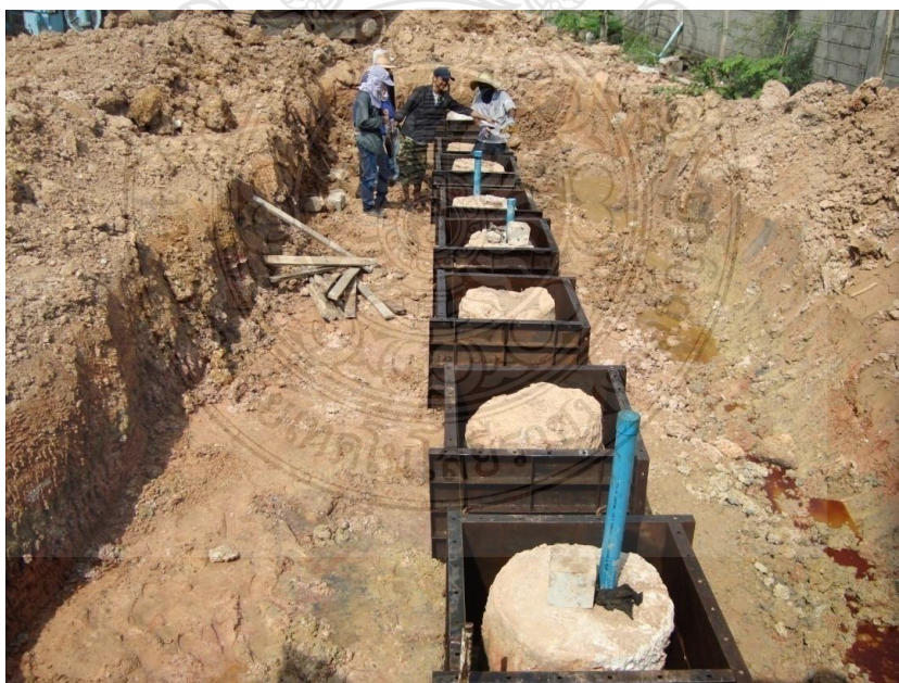
ภาพที่ ฉ.18 การเตรียมพื้นที่และตีแบบหล่อคอนกรีตครอบหัวเสาเข็ม
