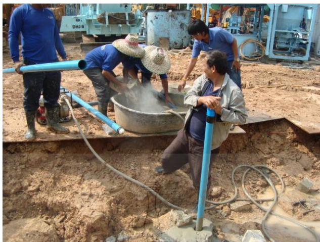
ภาพที่ 3.21 การฝังท่อ Incliner Casing
