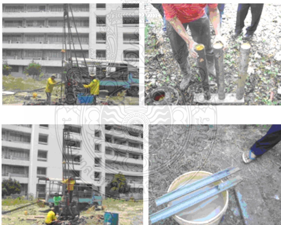
ภาพที่ 3.2 การเจาะสำรวจดินและเก็บตัวอย่างดิน
