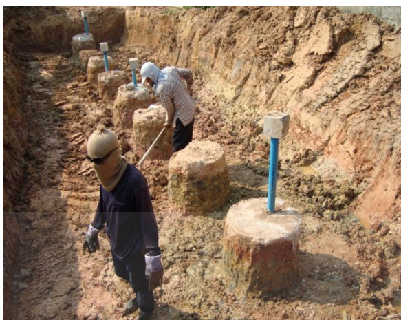
ภาพที่ 3.4 การก่อสร้าง DCM และ SDCM Column ในแปลงทดสอบ
