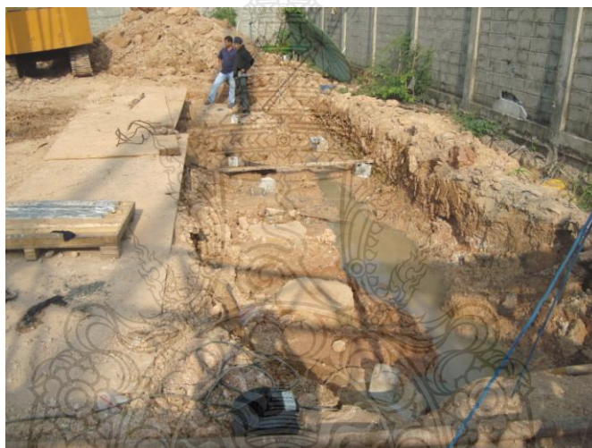
ภาพที่ 3.20 การขุดเปิดหัวเสาเข็มและเตรียมพื้นที่
