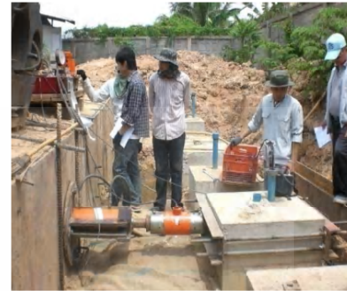
รูปที่ 5 รูปการติดตั้งระบบแรงปฏิกิริยา DEADMAN ตามมาตรฐาน (ASTM D3966)
