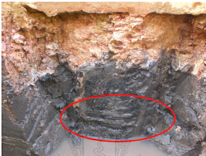
ภาพที่ 4.18 ร่องรอยการวิบัติของเสาเข็มดินซีเมนต์ที่ไม่มีการเสริมแกน (C1)
