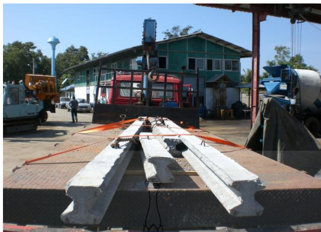
ภาพที่ 3.6 เสาเข็มคอนกรีตอัดแรงรูปตัว I ขนาด 0.180 \times 0.18 ยาว 6 เมตร
