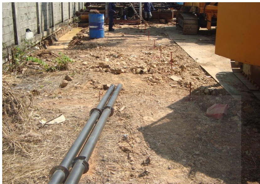
ภาพที่ ฅ.1 การวางเตรียมพื้นที่และกำหนดตำแหน่งก่อสร้าง
