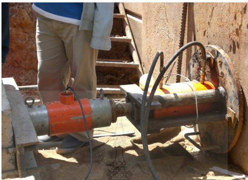
ภาพที่ ฌ.21 ลักษณะการติดตั้งระบบให้แรงในการทดสอบ
