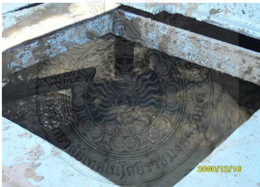
ภาพที่ ฅ.4 ถังผสมทำการผสมน้ำและปูนผงเข้าด้วยกัน
