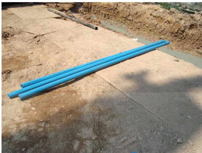
ภาพที่ 3.13 Inclinometer Casing ที่ใช้ทำการทดสอบ
