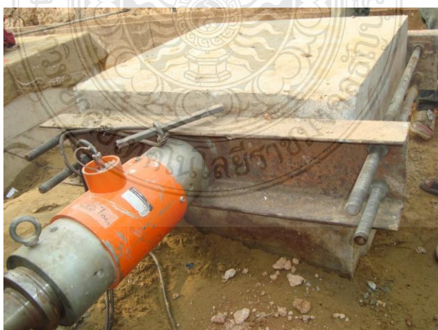
ภาพที่ 3.26 ยึดหัวเสาเข็มเข้ากับอุปกรณ์เพื่อทำการทดสอบ
