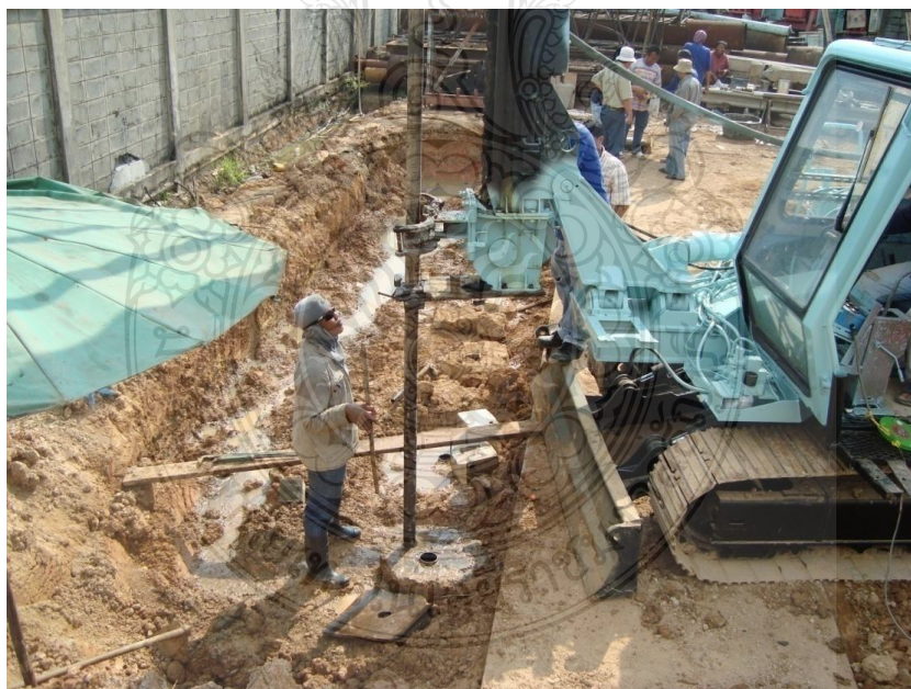
ภาพที่ ๗.๑๐ เมื่อเสาเข็มอายุ 28 วันทำการเจาะเก็บตัวอย่างเนื้อเสาเข็ม
