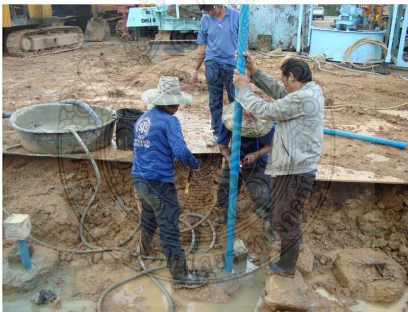
ภาพที่ ฉ.16 การฝังท่อ Inclinometer Casing ที่ใช้ทำการทดสอบ
